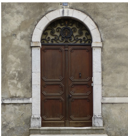
Menuiserie XVIII e à panneaux en bois, surmontée d'une grille en fer forgé en imposte
