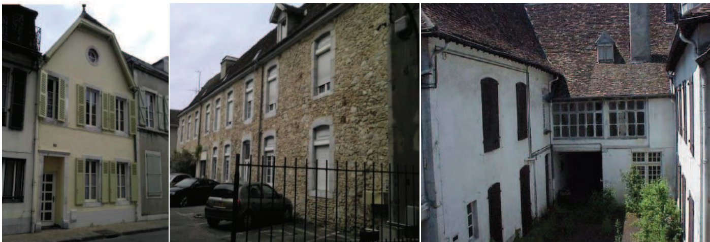
Maisons mitoyennes du centre et des faubourgs anciens. Différentes typologies sont observables : façades étroites et larges, nombres de niveaux avec ou sans combles aménagés, maisons organisées autour d'une cour; appareil de pierre tout venant.
