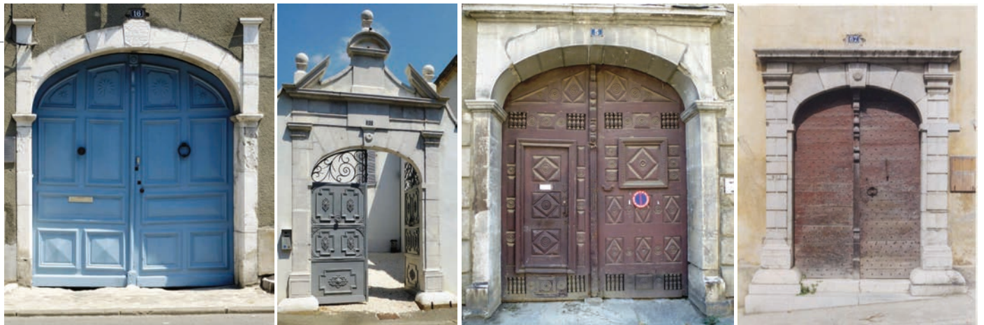
Portes charretières et portails
