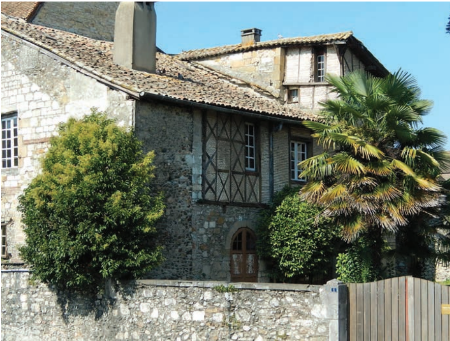
Maison Batcave, rue Lasserre, extension en pans de bois du noyau primitif médiéval (partie récente) la proportion des grandes baies et les traces d'assemblage (trous de chevillage) semblent correspondre à une fenêtre à croisée, sensiblement contemporaine des modèles en pierre
