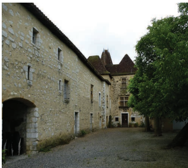
Intégration et remaniement de constructions anciennes – façade arrière sur cour et jardin (pigeonnier) – maison Jeanne d'Albret.
