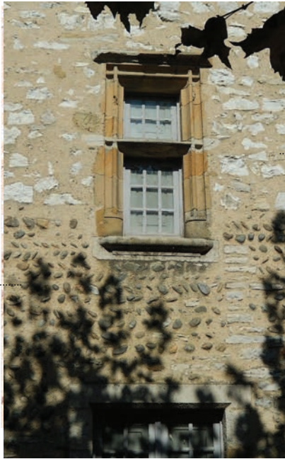
Enduit à pierre rase sur maçonnerie en moellons de calcaire
