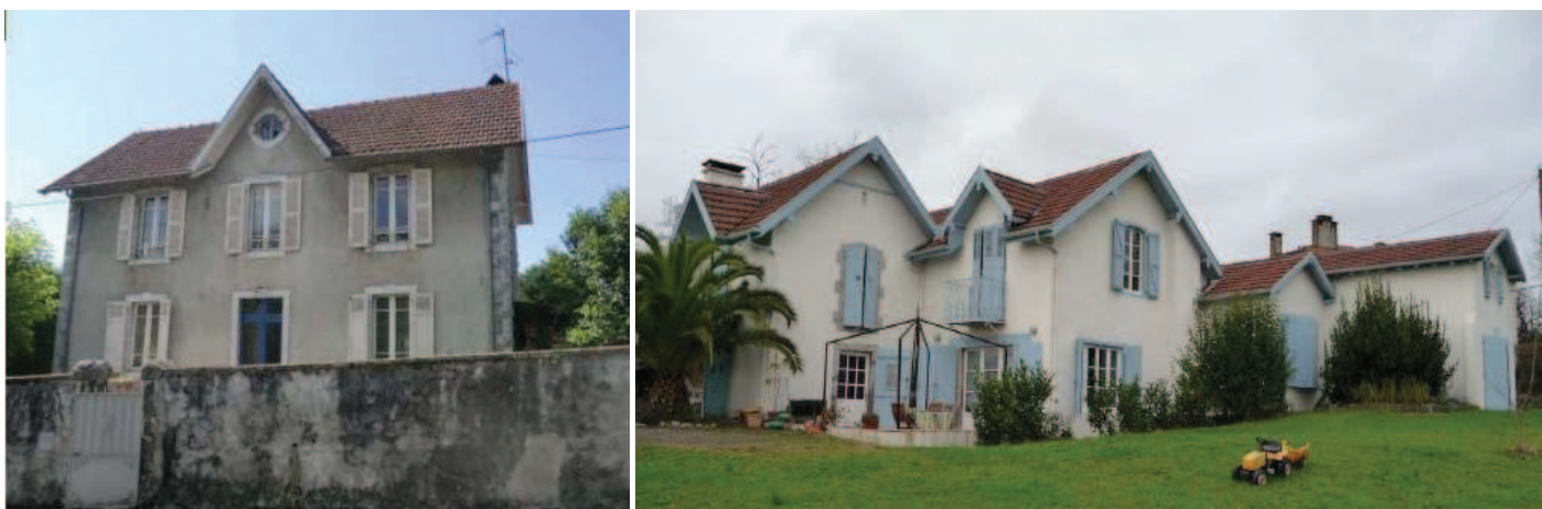
Maisons anciennes non mitoyennes des faubourgs. (fin XIX e– 1 er tiers du XX e). Différentes typologies, maison sur plan massique à gauche et maisons sur plan en L à droite; différents matériaux : blocs de béton plein, appareil de pierre tout venant.
