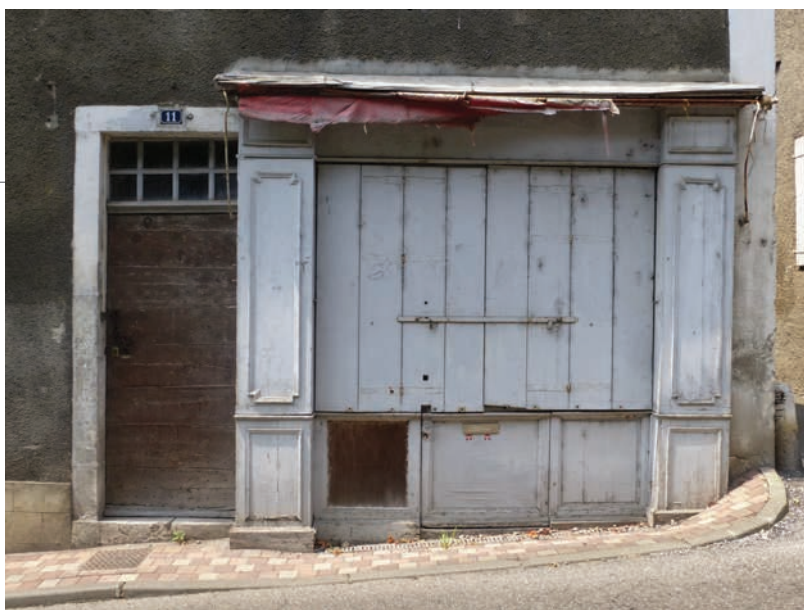
Devanture menuisée en applique avec ses ais de fermeture et son store
