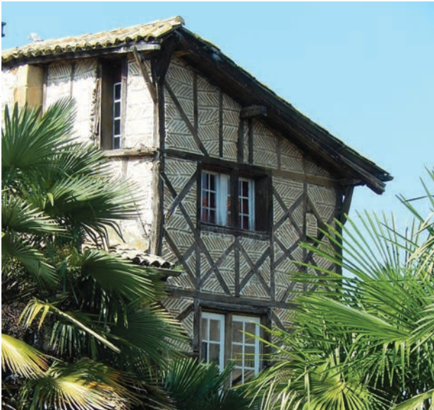
Maçonnerie en pan de bois et briques en opus spicatum.
