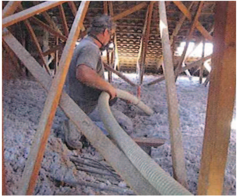
Principe de l'isolation des combles non praticables par insufflation d'isolants en vrac. Source : L'isolation thermique écologique, Oliva et Cougey, 2010
