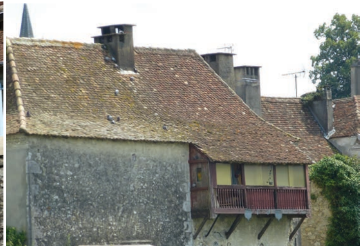
Mirande sur rue et lambrequin de bois découpés aménagée sur un toit
