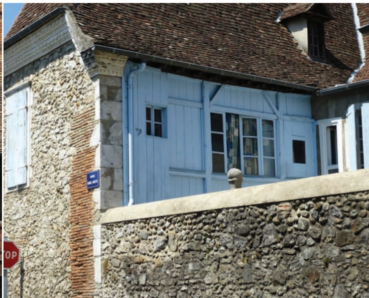
« Décroustage » des enduits de protection de la façade maçonnée en moellons.
