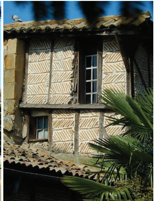
Maison Batcave, rue Lasserre, extension en pans de bois du noyau primitif médiéval (partie récente) la proportion des grandes baies et les traces d'assemblage (trous de chevillage) semblent correspondre à une fenêtre à croisée, sensiblement contemporaine des modèles en pierre
