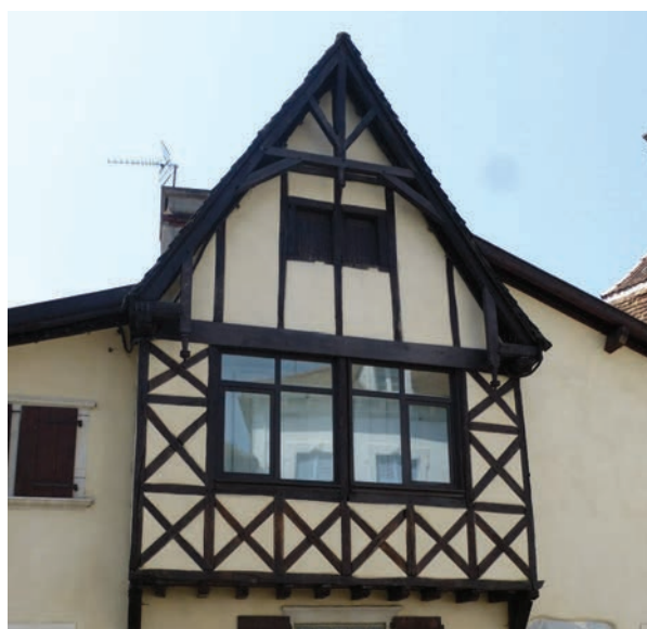
Pan de bois enduit et panneaux enduits.
