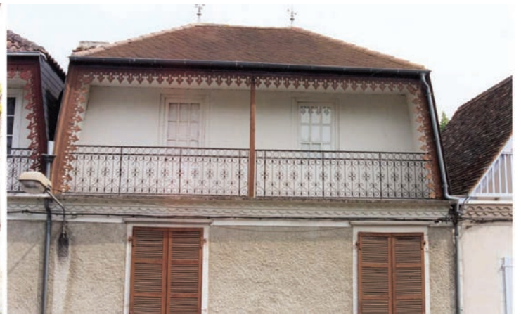
Mirande sur rue et lambrequin de bois découpés aménagée sur un toit
