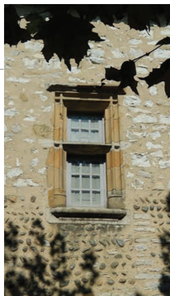
A gauche, Maçonneries anciennes remaniées et intégration de nouvelles baies en grès jaune de Montalibet. A droite baies XVI e siècle.
