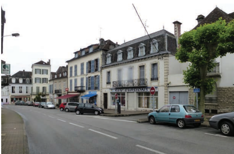
Immeubles de dimensions urbaine sur le nouvel espace public de la place Brossers.
