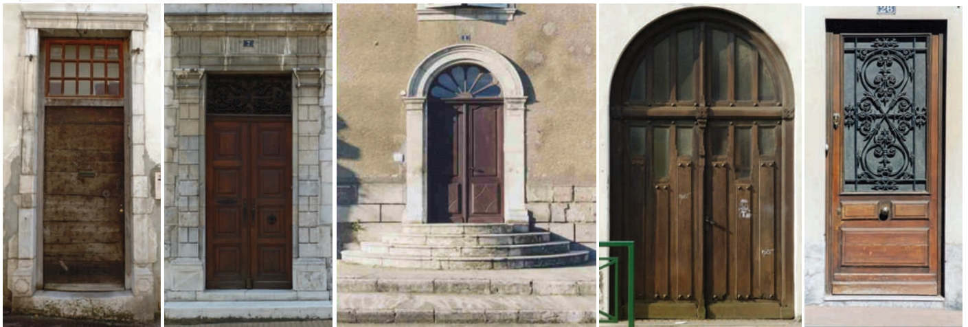
Portes, encadrements, perrons.
