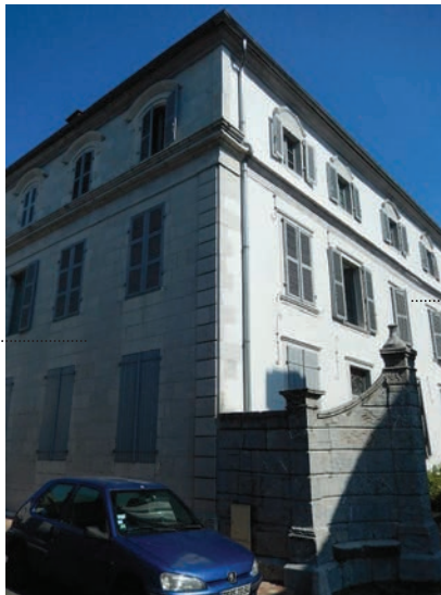
Façade principale sur rue en pierre de taille
