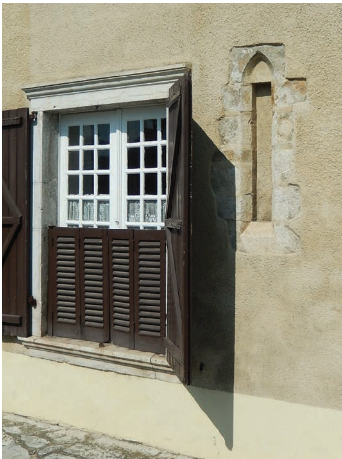
Rue des Aiguilletiers. A côté de la fenêtre moderne (XVIII e siècle), dans le même mur apparaît une baie beaucoup plus ancienne.
