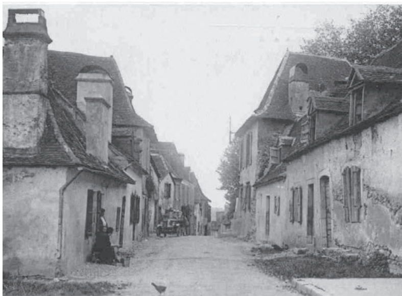
Vue ancienne de l'entrée du bourg Moncade : cheminées, mitres, lucarnes et descentes d'eaux pluviales
