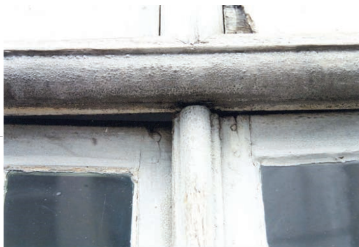
Détail de la croisée d'une fenêtre.
