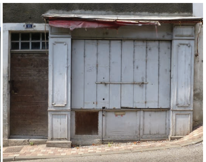
La devanture menuisée en applique sur la façade. La devanture n'intègre pas la porte d'entrée de l'immeuble.. La devanture est encore équipée de ses ais de fermeture et de son store-banne.
