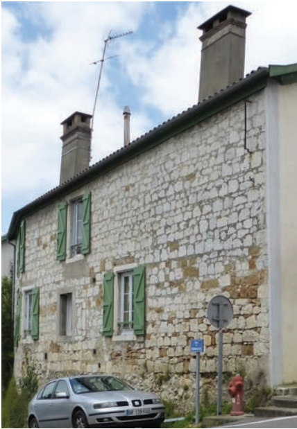
Maçonnerie en pierre taille assisée.
