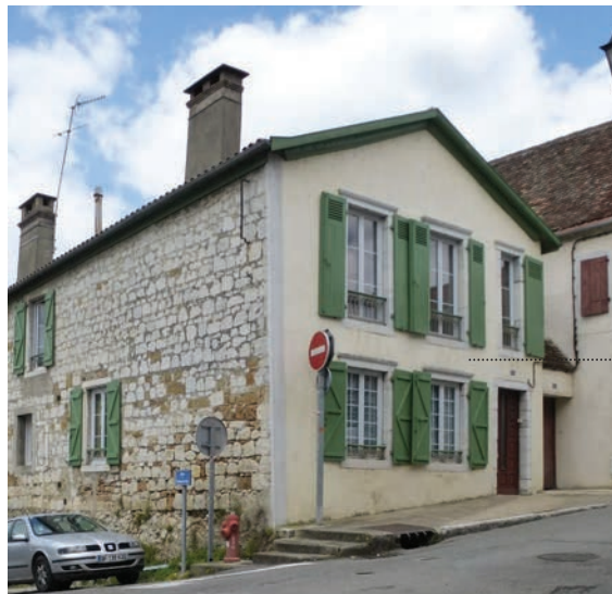
Encadrements en calcaire laissés apparents
