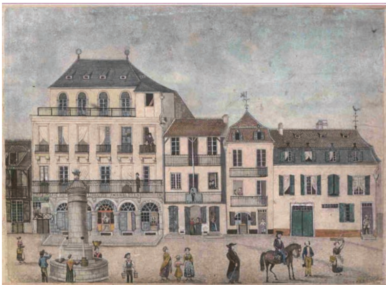
Grand immeuble place Saint-Pierre. Dessin G. Provençal, 1849.
